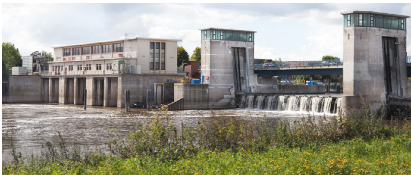
Bild 1: Laufwasserkraftwerk Drakenburg an der Weser
