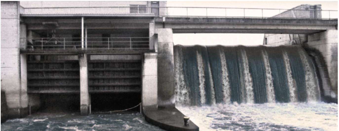
Bild 14: Am Standort Wahnhausen wird das Wehrfeld neben dem Kraftwerk bei aalschonendem Betrieb so stark beaufschlagt, dass sich der Turbinendurchfluss auf weniger als 30 m 3 /s reduziert und damit die Anströmungsgeschwindigkeit vor dem Rechen auf maximal 0,5 m/s verringert wird (Foto: B. Adam)
